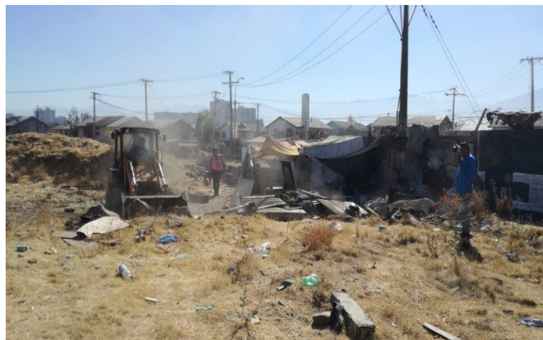
Retiro de PSC sector estacionamientos estadio.
