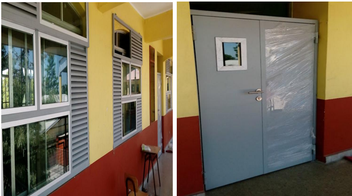
(Imágenes 1: corresponde a primer avance de las obras)
